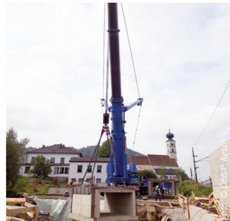
Letzte Betonteile werden eingebaut. Mit Jahresende geht die Unterführung Altmannbach in Betrieb.
