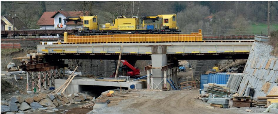
Der Brückenein Schub der Lindenbachbrücke wird minutiös vorbereitet.
