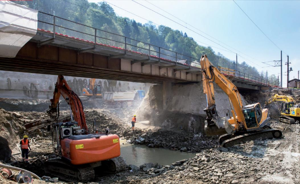
Aktuell wird in mehreren Bereichen gebaggert und betoniert, um die neuen Unterführungen zügig herzustellen. Im Bild Straßenunterführung Wernstein Süd.
